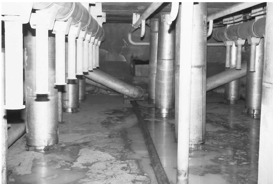
Рис. 5. Скопление среднеактивных ЖРО на нижних отметках ОУ.
